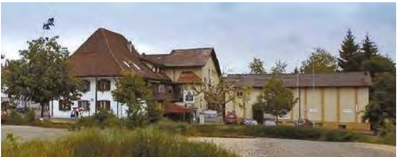
Ansicht des St. Urs mit dem rückwärtigen Bau welcher heute als Dienstleistungsbetrieb für Bürobedarf genutzt wird
